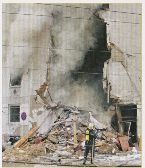
Říběch plynu v Brně na ulici Tržní.
