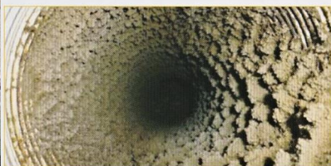
Zanesená kominová vložka pro spotřebič na zemní plyn.
